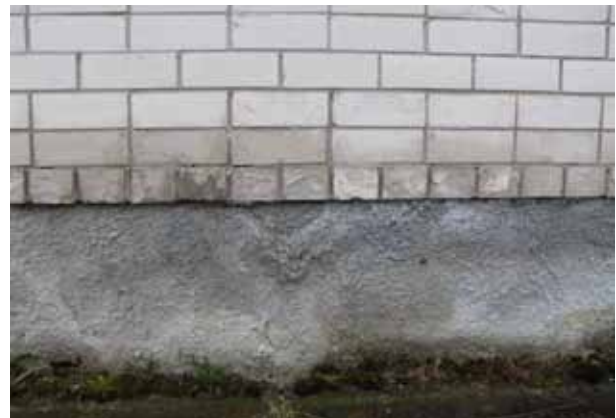
Joonis 2.7 Eriti tugev on probleem suurema vihma/veekoormusega kohtades, näiteks parapeti (vasakul) või sokli (paremal) juures.
