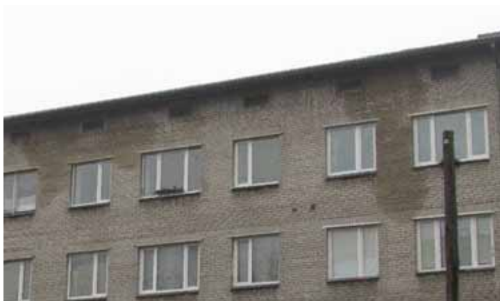
Joonis 2.26 Katuse lekke (vasakul) ja katuselt seinale langenud vee tõttu kahjustunud ülemise korruse välisseinad.
