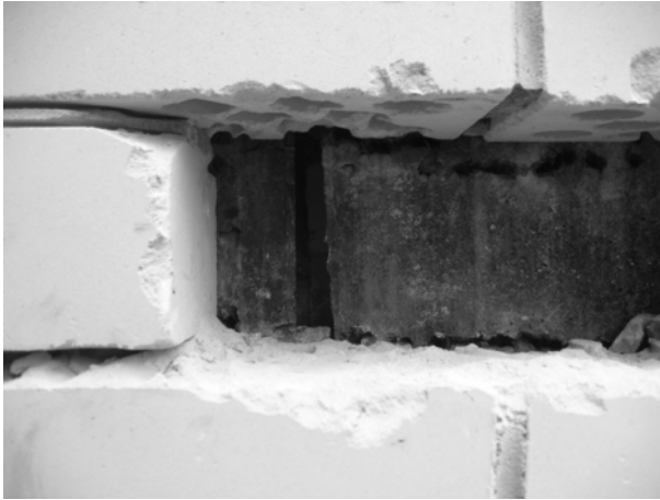
Joonis 2.2 Tellisvoodri ja soojustuse vahel võib olla tõrvapapp või ruberoid.
