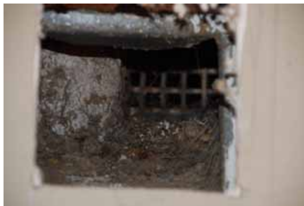
Joonis 10.5 Korterites paiknevad väljatõmbekanalitesse on aastate jooksul kogunenud mustust ja tolmu (paremal) ning ventilatsiooniseadmed on hooldamata (vasakul).
