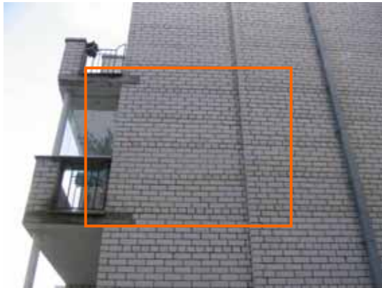
Joonis 3.8 Sidekiviread välisseinas.
