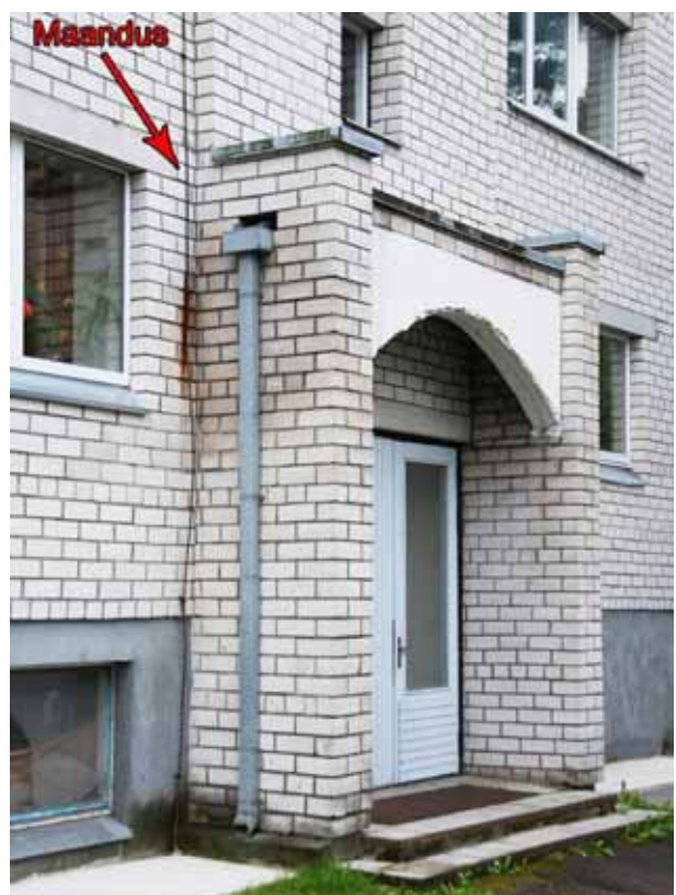
Joonis 2.13 Mööda kaableid fassaadile sattuv vesi põhjustab telliste lagunemise.
