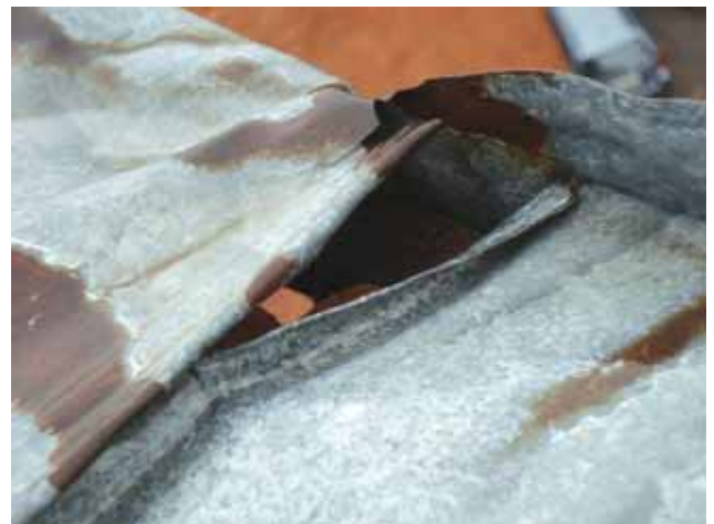
Joonis 2.25 Tüüpilised kaldkatuste läbijooksu kohad on korstnate, katuseluukide ja teiste katusest läbiviikude juures (vasakul).
