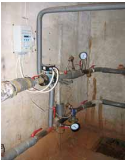
Joonis 10.9 Keldris paiknevate küttetorude puudulik soojustus.
