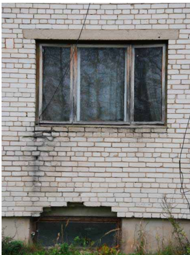
Joonis 2.13 Mööda kaableid fassaadile sattuv vesi põhjustab telliste lagunemise.
