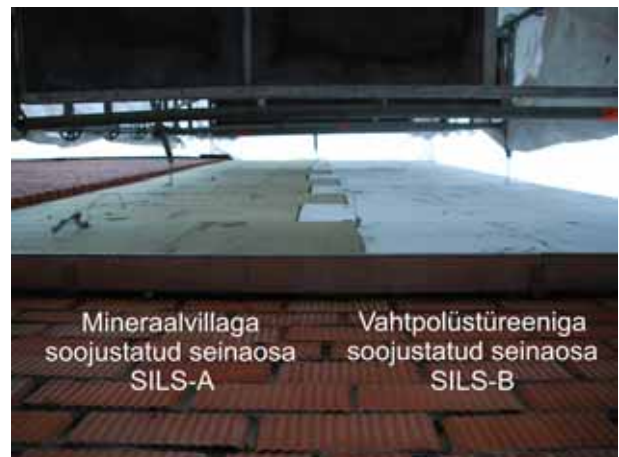
Joonis 5.11 Uuritud seinaposa asus 4. korrusel (vasakul). Korstnapoolne e. vasakpoolne seinaposa oli soojustatud mineraalvillaga e. SILS-A; nurgapoolne e. parempoolne seinaposa oli soojustatud vahtpolüstüreeniga e. SILS B (paremal, foto on tehtud seinatasepinna, alt üles).
