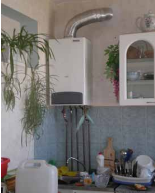
Joonis 10.8 Korteris paiknev lokaalne gaasikatel või soojuspump ruumide kütteks ja/või tarbevee soojendamiseks.
