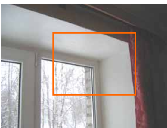
Joonis 3.5 Lodža liitumine välisseinaga.
