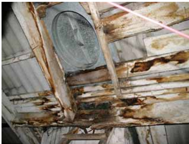
Joonis 2.25 Tüüpilised kaldkatuste läbijooksu kohad on korstnate, katuseluukide ja teiste katusest läbiviikude juures (vasakul).
