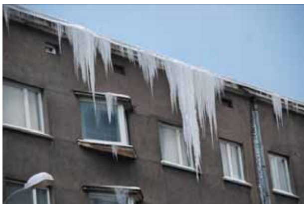
Joonis 2.28 Jääpurikad katuseräästas on kindel märk katuse puudulikust soojustusest.
