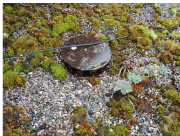
Joonis 2.27 Veekahjustustega katusekonstruktsioonid (paremal). Katusel kasvav taimestik takistab vee äravoolu ja kahjustab katusekatet (vasakul).
