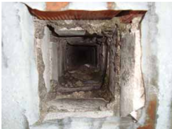
Joonis 10.3 Ventilatsioonikanalite ehituskvaliteet on halb ning seinad suure karedusega (vasakul ja paremal).
