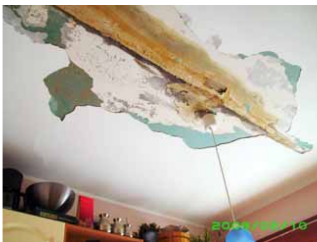
Joonis 2.27 Veekahjustustega katusekonstruktsioonid (paremal). Katusel kasvav taimestik takistab vee äravoolu ja kahjustab katusekatet (vasakul).
