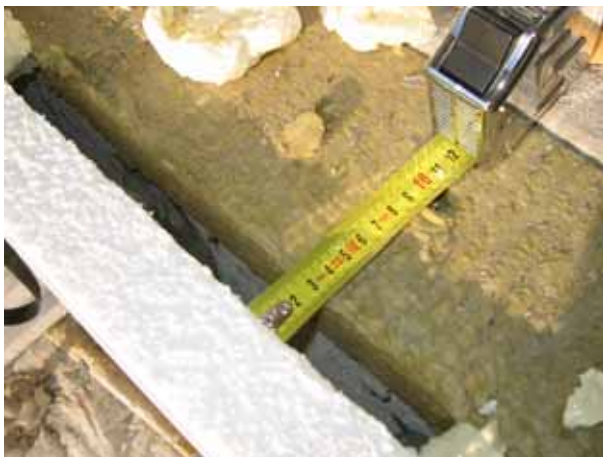
Joonis 13.5 Ebakvaliteetselt paigaldatud lisasoojustus: ei ole kasutatud soojustuse tasapinnalist liimimist ja välisõhk pääseb soojustatava seina ning soojustuse vahele.
