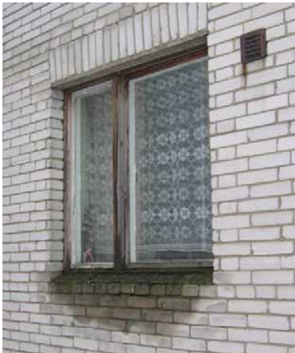
Joonis 2.12 Puudulikud katteplekid tekitavad telliste lagunemise.
