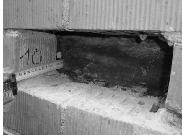
Joonis 2.2 Tellisvoodri ja soojustuse vahel võib olla tõrvapapp või ruberoid.
