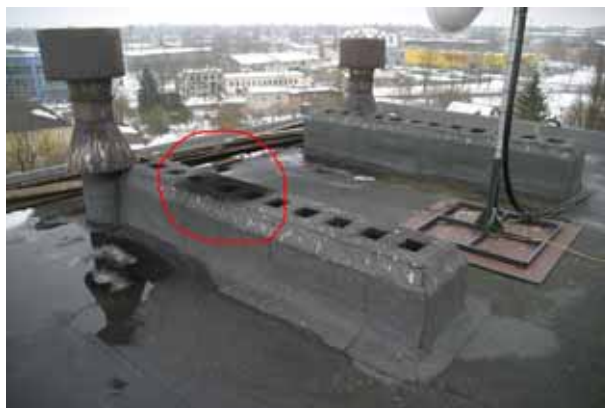
Joonis 10.4 Linnud ehitavad ventilatsioonilõõridesse pesasid ja mustavad õhukanaleid (vasakul) või kasutatakse lõõre selleks mitte ettenähtud eesmärgil (paremal).
