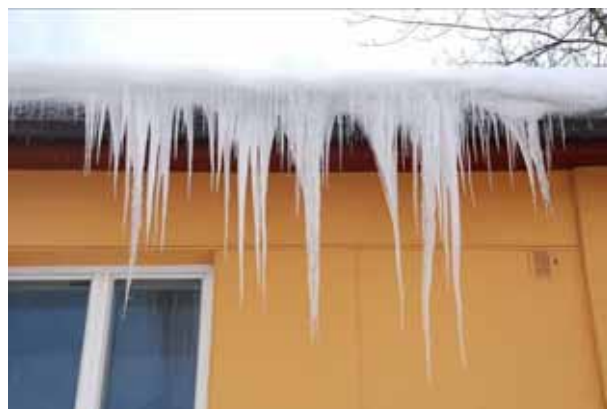
Joonis 2.28 Jääpurikad katuseräästas on kindel märk katuse puudulikust soojustusest.
