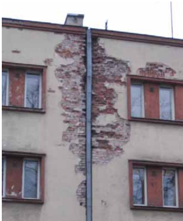
Joonis 2.11 Seina uputanud vihmaveetoru võib kõrvaldamata lekke korral suurt kahju tekitada. Külma kindlus on ammendunud ka mõned aastad tagasi asendatud tellistel (all paremal).
