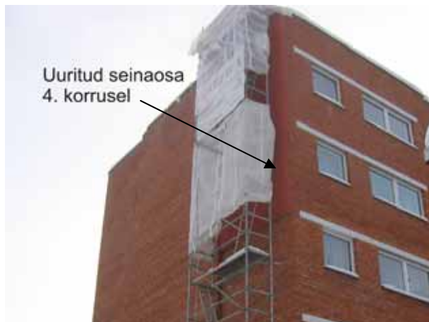
Joonis 5.11 Uuritud seinaposa asus 4. korrusel (vasakul). Korstnapoolne e. vasakpoolne seinaposa oli soojustatud mineraalvillaga e. SILS-A; nurgapoolne e. parempoolne seinaposa oli soojustatud vahtpolüstüreeniga e. SILS B (paremal, foto on tehtud seinatasepinna, alt üles).
