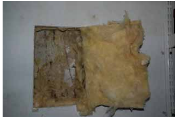
Joonis 5.33 Mõõdetud temperatuur ja suhteline niiskus lisasoojustatud seina sees on soodsad hallituse tekkeks (vasakul). Seestpoolt lisasoojustatud tellissein on kaetud veeauru kondensaadiga ja hallitusega (paremal).
