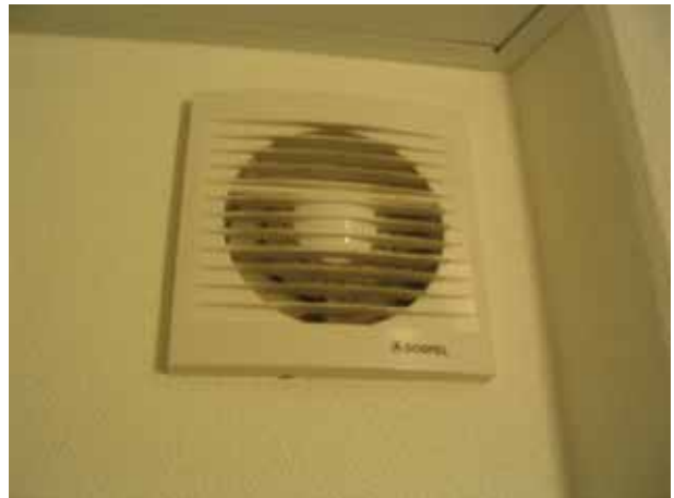
Joonis 10.6 Väljatõmbeavad on kinni kaetud (vasakul) ja sanitaarruumidesse on paigaldatud väljatõmbeventilaatorid (paremal)
