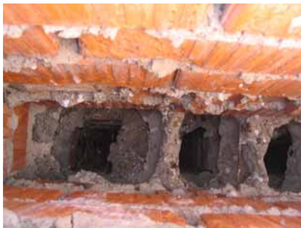
Joonis 10.3 Ventilatsioonikanalite ehituskvaliteet on halb ning seinad suure karedusega (vasakul ja paremal).
