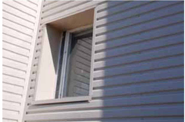
Joonis 13.10 Vältimaks välisseinte lisasoojustamisel akende „auku“ jäämist tuleks aknad tõsta olemasoleva välisseina välispinda.
