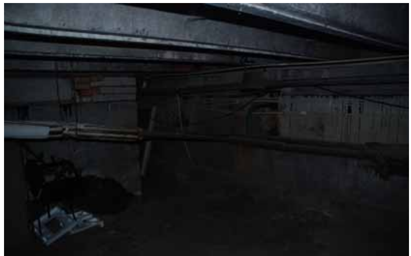
Joonis 10.9 Keldris paiknevate küttetorude puudulik soojustus.
