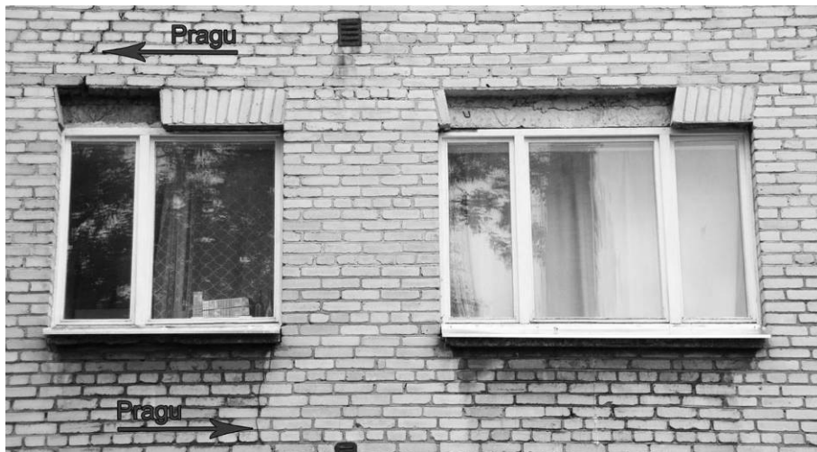
Joonis 2.17 Purunenud tellissillused, samuti on näha praod ja kunagisest aknapleki puudumisest kahjustunud tellised.
