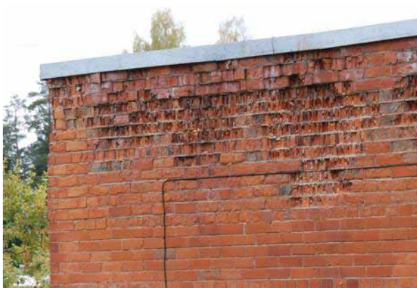
Joonis 2.7 Eriti tugev on probleem suurema vihma/veekoormusega kohtades, näiteks parapeti (vasakul) või sokli (paremal) juures.
