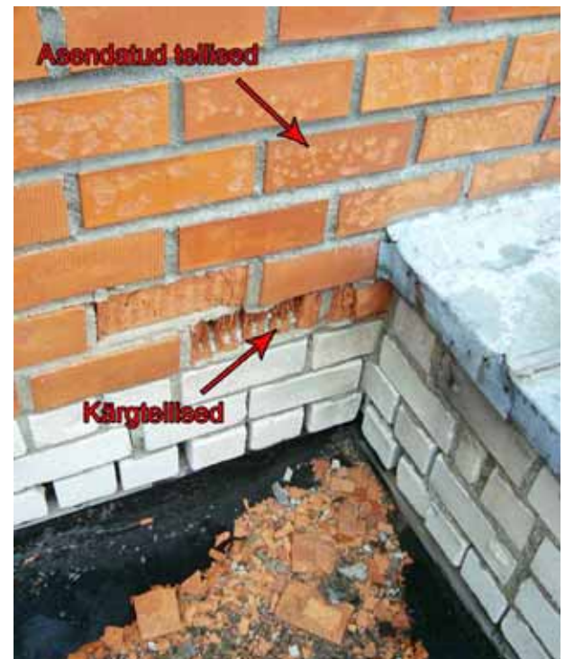
Joonis 2.11 Seina uputanud vihmaveetoru võib kõrvaldamata lekke korral suurt kahju tekitada. Külma kindlus on ammendunud ka mõned aastad tagasi asendatud tellistel (all paremal).
