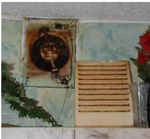
Joonis 10.5 Korterites paiknevad väljatõmbekanalitesse on aastate jooksul kogunenud mustust ja tolmu (paremal) ning ventilatsiooniseadmed on hooldamata (vasakul).
