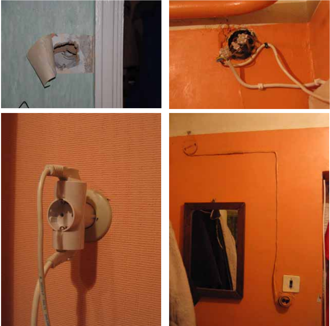
Joonis 10.11 Lahtiseid elektrikaableid korteris (üleväl) ja pistikupesade ülekoormamine (all) on elektriohutust silmas pidades väga riskantsed.
